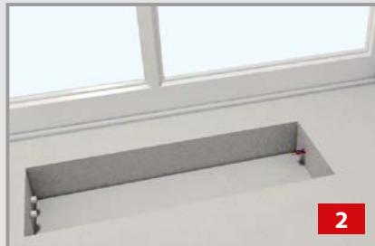
**4.** Изолировать стенки и дно со стороны теплообменника - теплоизоляцией, стенки и дно со стороны вентилятора - шумоизоляцией. Заполнить пустоты уплотнительным материалом.
